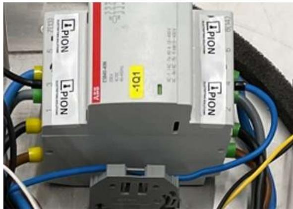
**Abbildung 2: Siegelklebeband auf Leistungsschutz**
