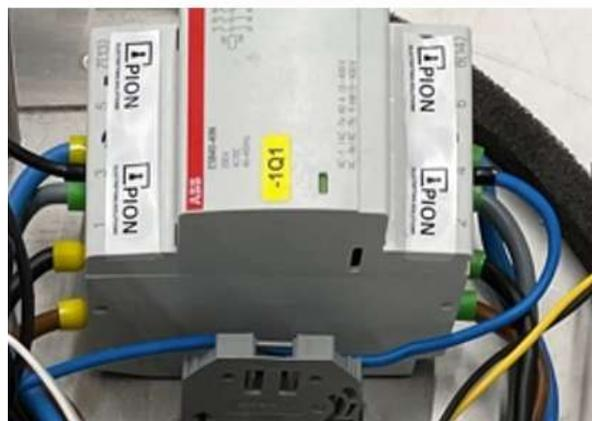
**Abbildung 2: Siegelklebeband auf Leistungsschutz**
