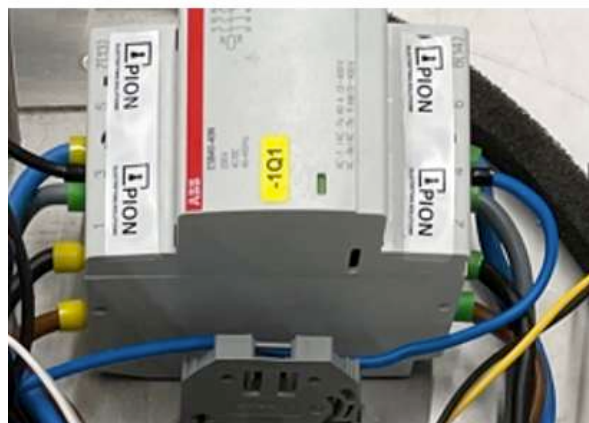
Abbildung 2: Siegelklebeband auf Leistungsschütz
